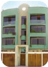
Edif. Trevor San Borja
