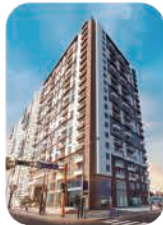
Edif. Ser-k 2da Etapa Barranco
