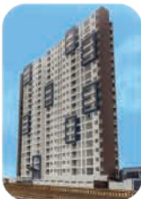
Edif. Barranco V.C. Barranco
