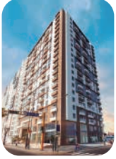
Edif. Ser-k 2da Etapa Barranco
