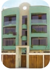
Edif. Trevor San Borja
