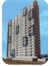
Edif. Barranco V.C. Barranco
