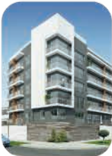
Edif. Módena Barranco
