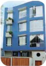
Edif. Atahualpa Miraflores
