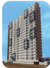
Edif. Barranco V.C. Barranco
