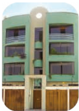
Edif. Trevor San Borja
