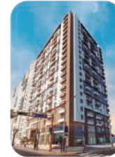
Edif. Ser-k 2da Etapa Barranco
