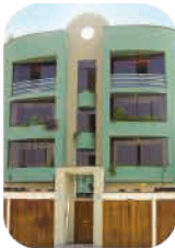
Edif. Trevor San Borja
