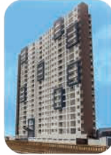
Edif. Barranco V.C. Barranco
