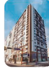
Edif. Ser-k 2da Etapa Barranco
